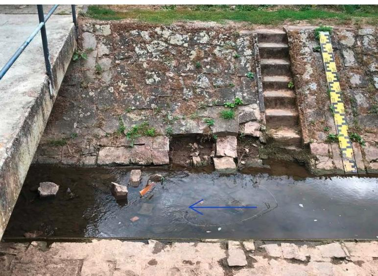
*Schadhafte Uferböschung im Bereich des Pegels Gaugrehweiler vor der Sanierung*
