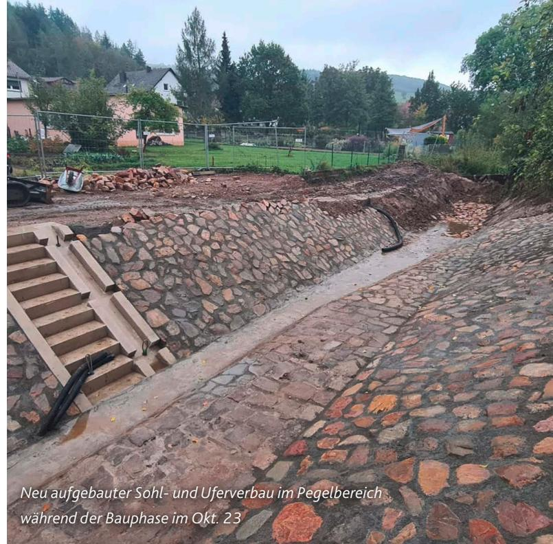
Neu aufgebauter Sohl- und Uferverbau im Pegelbereich während der Bauphase im Okt. 23
