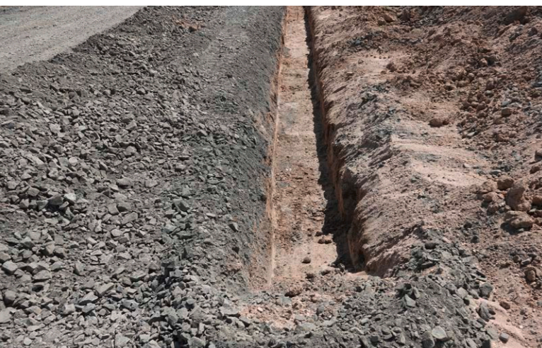
Die Baumaßnahmen haben begonnen
