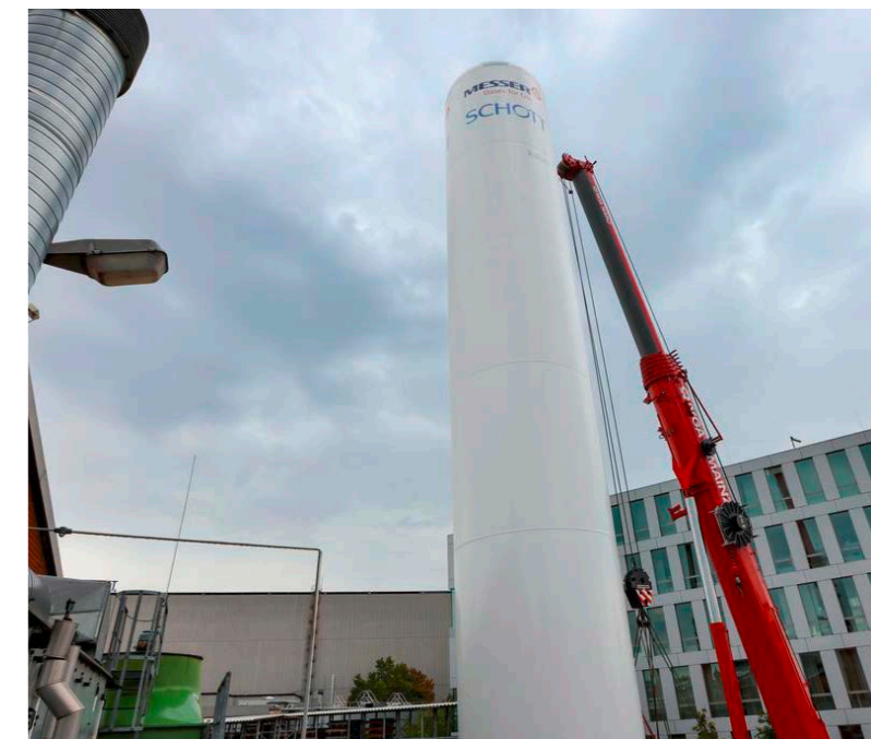
20 Meter hoher Wasserstofftank bei der Schott AG
