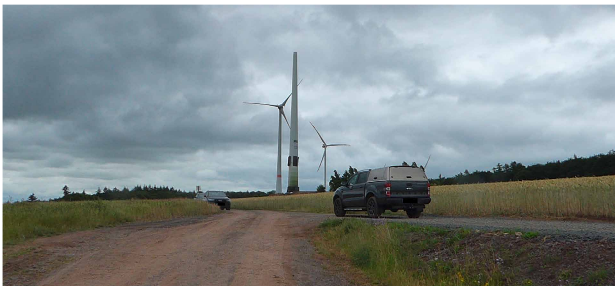
Vorbereitungen für die Sprengung
