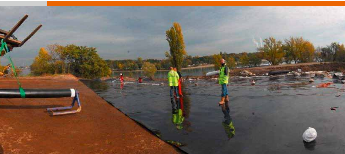
Laufende Arbeiten zur Folienverlegung (Quelle: Asmus API)
