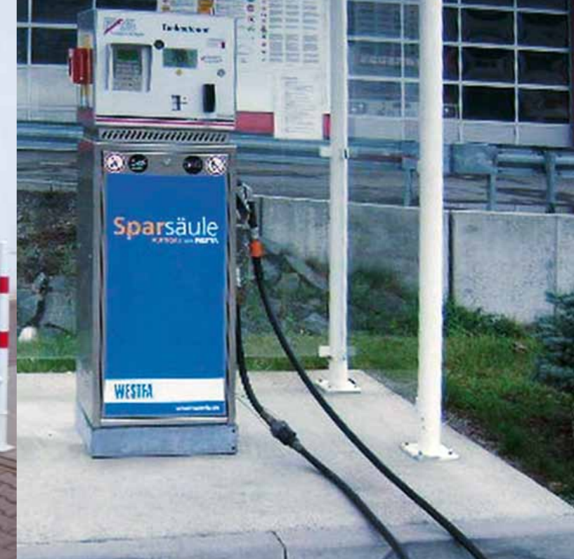
Die Explosionschutzzone ragt in ein Nachbargrundstück hinein Hier droht beim Überfahren Beschädigung des Zapfschlauchs
