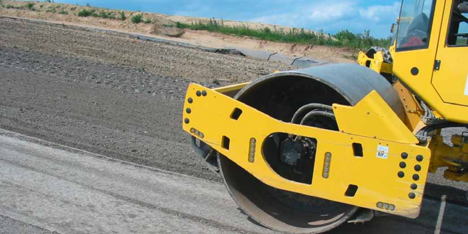
Aufbringung einer Schutzlage
