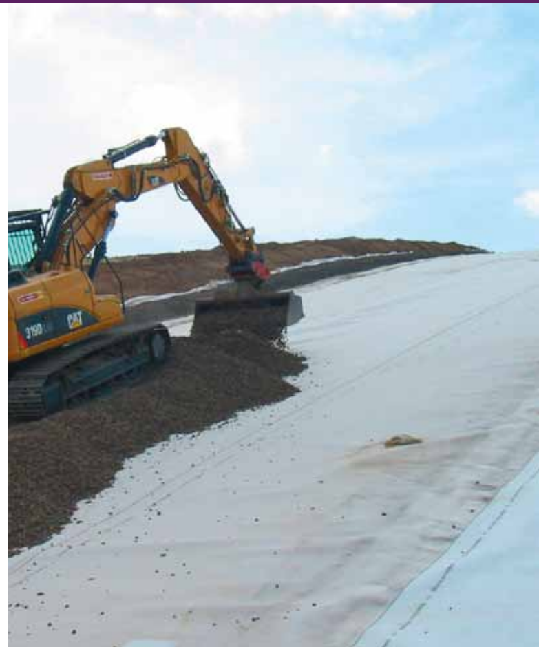
Verlegung mineralischer Schicht
