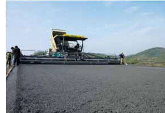
Raupenfertiger SUPER 2100-2 mit Einbaubohe SB 250 TP1 – aufgenommen in China, Provinz Hunan beim Bau eines 110 km langen Autobahnabschnitts.
