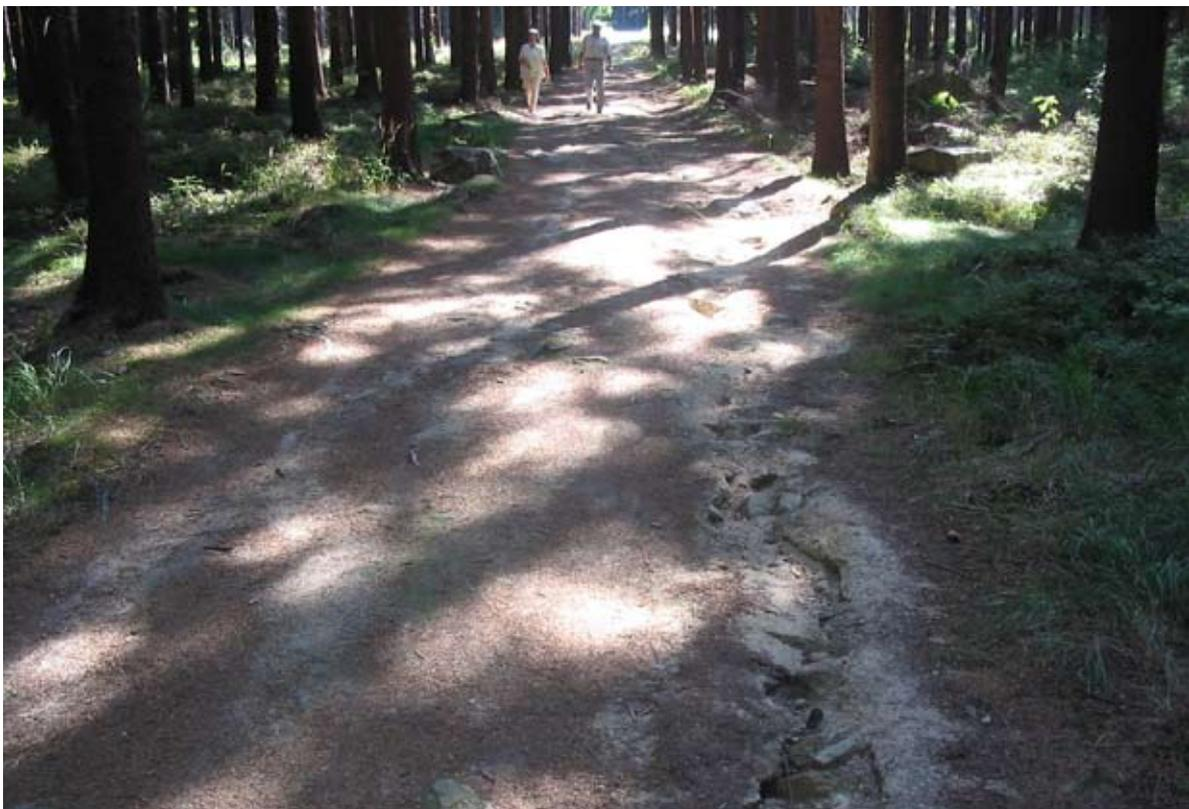
**Bild 5: Oberflächenabfluss und Erosion auf Waldweg**
