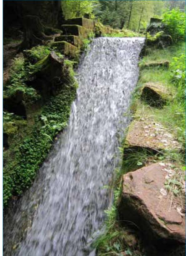
Über diese Rampe, früher als Riesel bezeichnet, sollte das Triftholz starkes Gefälle schadlos überwinden
