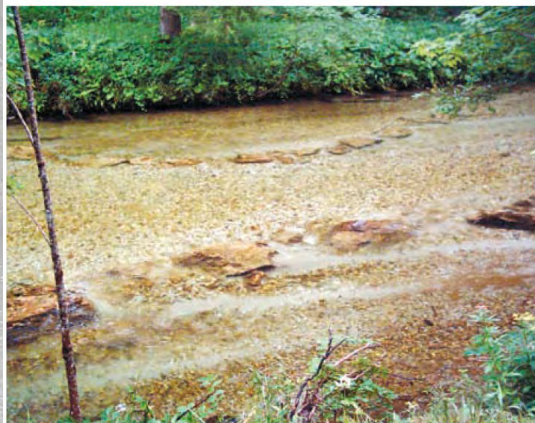
Bild 3: Deklinanter Strömungstrichter aus Lenkbuhnen in der Salza, Steiermark, (Kronberger, Schindler, 2005) (Foto: GfH, 2005)
