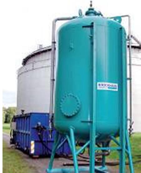
**Bild 2.9:** GAK als separater Druckfilter (Herbst et al., 2013)
