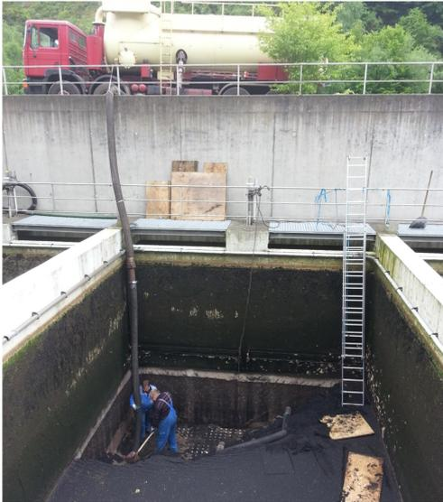
**Bild 2.8:** GAK als Ersatz für konventionelles Filtermaterial (Kolisch et al., 2014)
