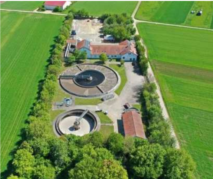
Abbildung 13: Luftbild der Kläranlage Flonheim ( www. Zweckverband-abwasserentsorgung-rheinhausen.de )
