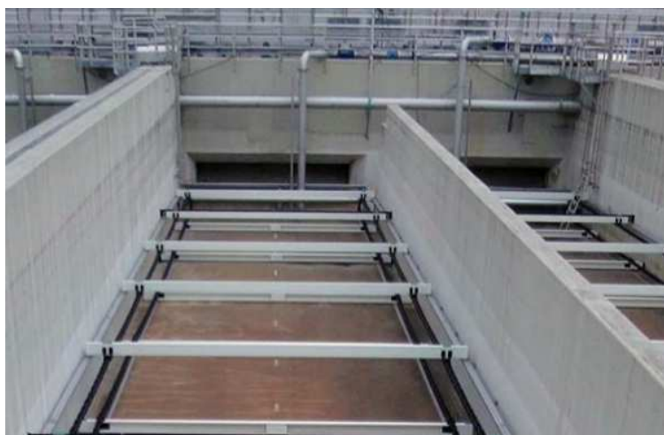
Abbildung 43: PAK Zugabe als Suspension (links) (Quelle https://nrw-mikro.amit-services.de/presse/anlagenfotos ) und Kettenräumer in einem längsdurchströmten Sedimentationsbecken (rechts) (Quelle: https://koms-bw.de/klaeranlagen/bilder_videos/ )
