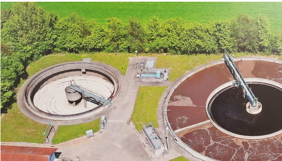
Abbildung 27: Luftbild RÜB, Ablaufschacht / Mikrosieb und Belebungsbecken
