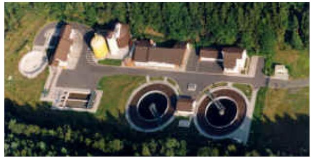
Die Kläranlage Felsalbe wurde ursprünglich für 30.000 EW konzipiert (Inbetriebnahme 1993). Vor einigen Jahren sollten zusätzlich 8.000 EW möglichst ohne bauliche Maßnahmen angeschlossen werden. Man entschied sich für die Schaffung zusätzlicher Kapazitäten durch einen fracht- und nährstoffoptimierten Betrieb der Anlage mittels moderner Mess-, Steuer- und Regeltechnik („Softwaretuning“).
