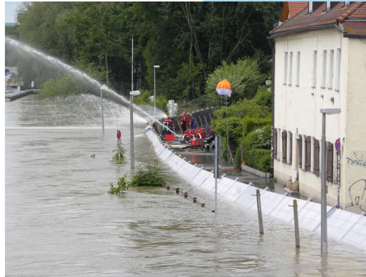
Foto: ©Gerhard Koller, WWA Regensburg, Einsatzkräfte beim Abpumpen hinter mobilen Elementen , Juni 2013
