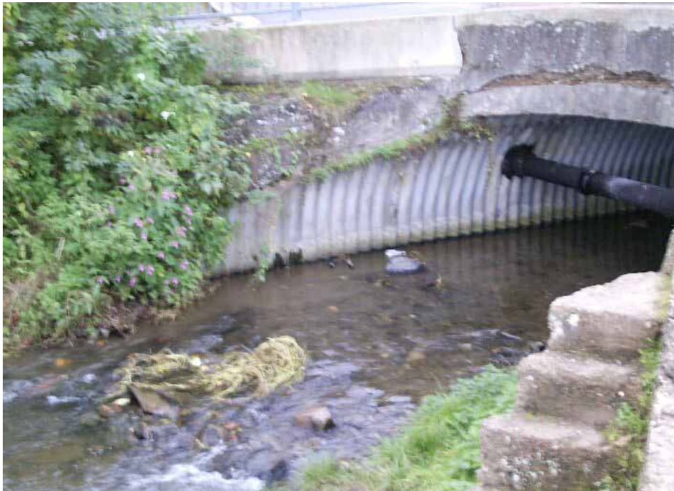
Abb. 3: Messstelle Brohlbach Mündung Mosel
