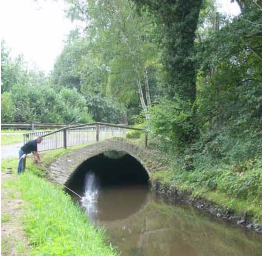
Abb. 22: Messstelle Flussgraben bei Harthausen
