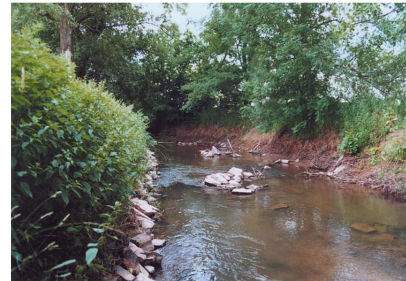
Bild 13 Einseitige Entnahme und unregelmäßiger Wiedereinbau des Uferverbaus (Pfrimm)
