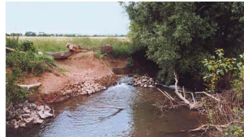
Bild 14 Punktueller Entnahme und unregelmäßiger Wiedereinbau des Uferverbau (Pfrimm)
