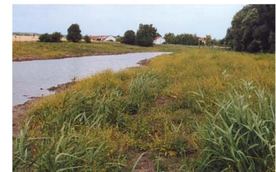
Bild 28 (links) Einseitige Gewässeraufweitung und Uferabflachung (Selz)
