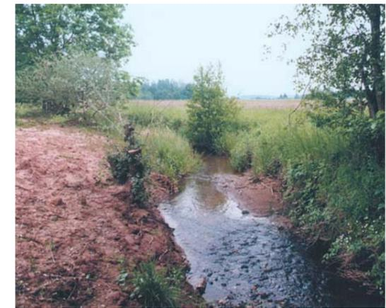
Bild 21 Uferabflachung und seitliche Aufweitung des Querprofils (Bleibach)
