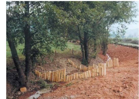
Bild 40 (links) Einbau von Pfahlreihen (Bauzustand) im Wäldersbach
