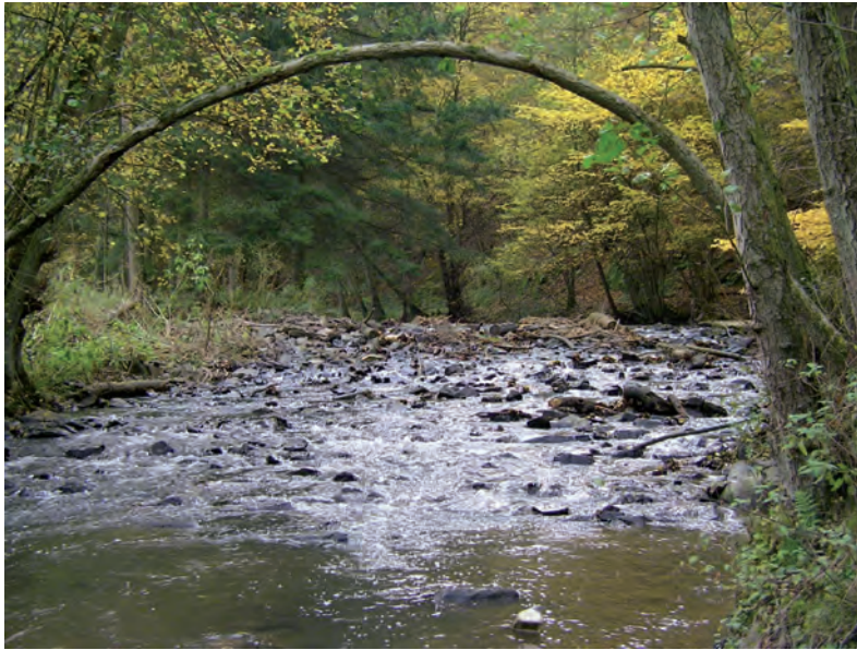
Abb. 4.7: Raue Rampe im Mühlbach bei hohem Abfluss. Die Wassertiefe auf der Rampe ist zu gering, daher Aufstiegsindex-Querbauwerk für Lachs 4. Abb. 4.8 zeigt ein Detail der Rampe.
