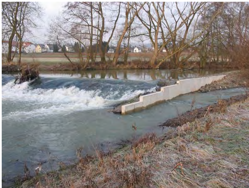
Abb. A.11: Umgehungsgerinne am Elbbach: der Einstieg befindet sich unmittelbar neben dem Wehr
