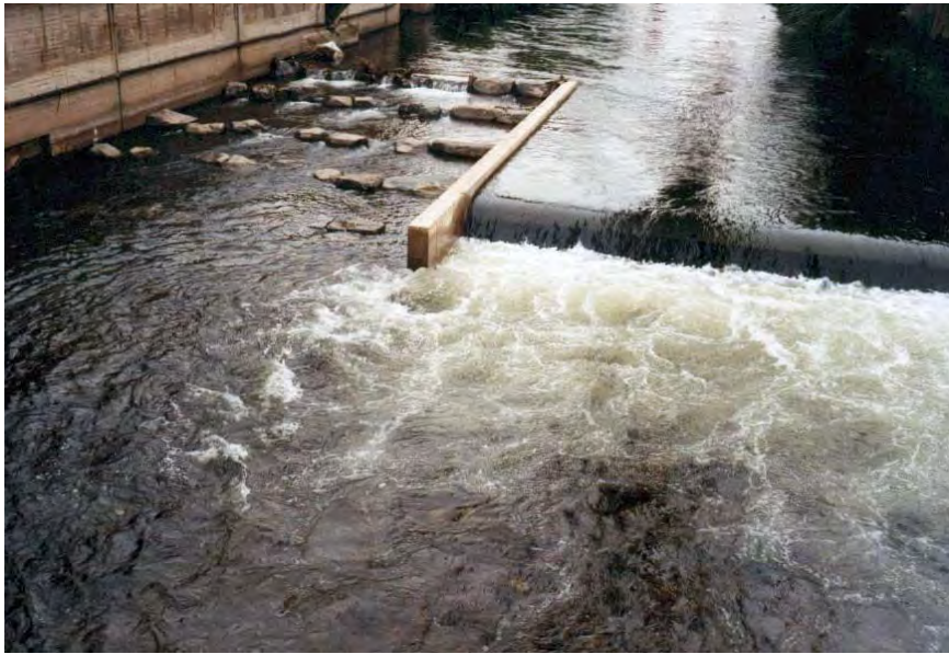
Abb. A.13: Fischaufstiegsanlage Wuppertal-Barmen mit Einstieg unmittelbar neben dem Tosbereich der Wehrklappe
