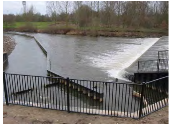
Abb. B. 15: Umgehungsgerinne Hambeek mit Riegelstruktur, rechts der optimierte Einstieg unmittelbar neben dem Wehr
