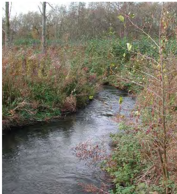
Abb. A.16: Umgehungsgerinne Beckinghausen (Lippe) ein Jahr nach seiner Inbetriebnahme
