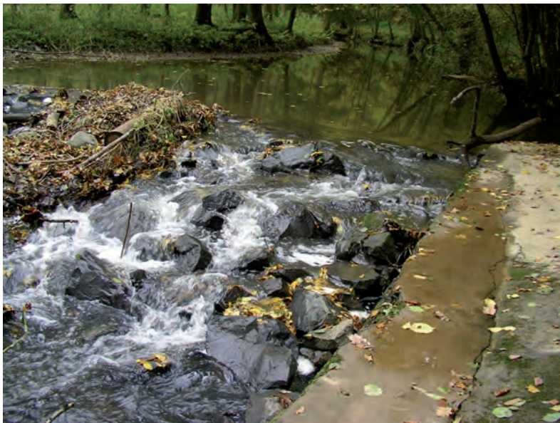
Abb. 4.8: Detail der Rauhen Rampe aus Abb. 4.7. Lachse würden sich beim Aufstieg verletzen, daher Aufstiegsindex-Querbauwerk für Lachs 4.
