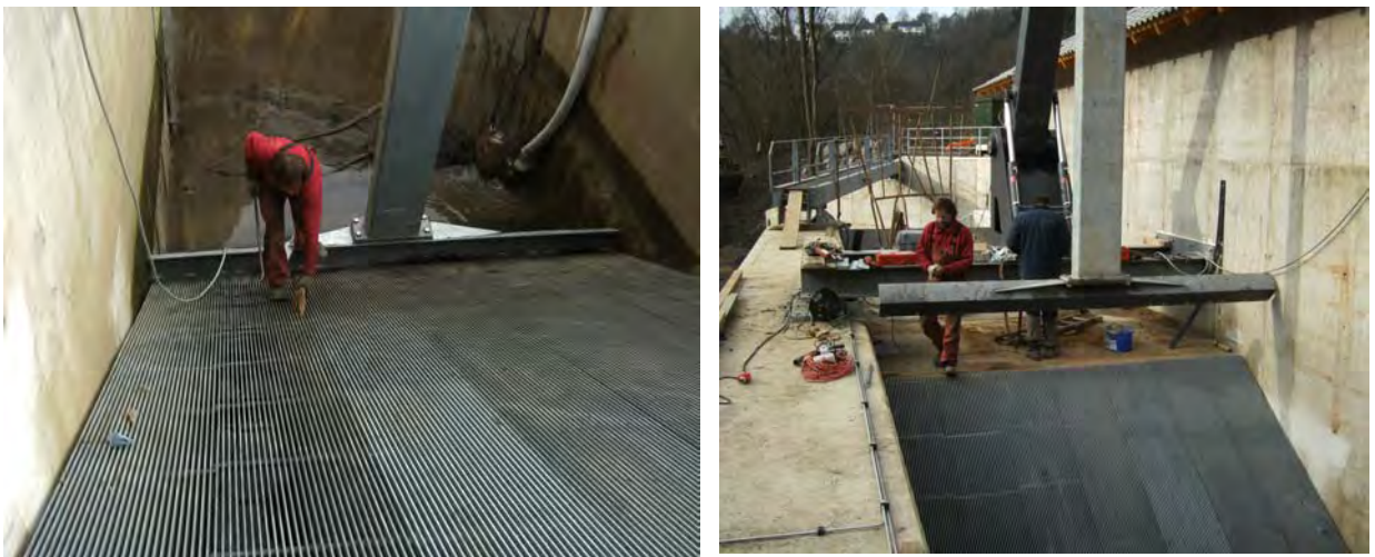
Abb. B. 14: Montage des 15 mm – Rechens und der Rechenreinigungsmaschine.
