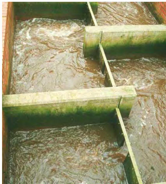
Abb. A.28: Kompakte Ausführung eines Schlitzpass ähnlichen Beckenpasses. Die hydraulische Berechnung kann nicht standardmäßig erfolgen (Heiligenrode, Brandenburg)
