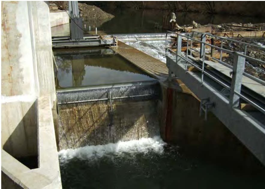
Abb. B. 11: Blick auf das eigentliche, überströmte Kraftwerk. Der Rechenreiniger befördert das Rechengut in den Kanal über der Turbine und es wird durch Öffnen der Klappe abgespült. Dieser Kanal fungiert gleichzeitig als oberflächennaher Bypass.
