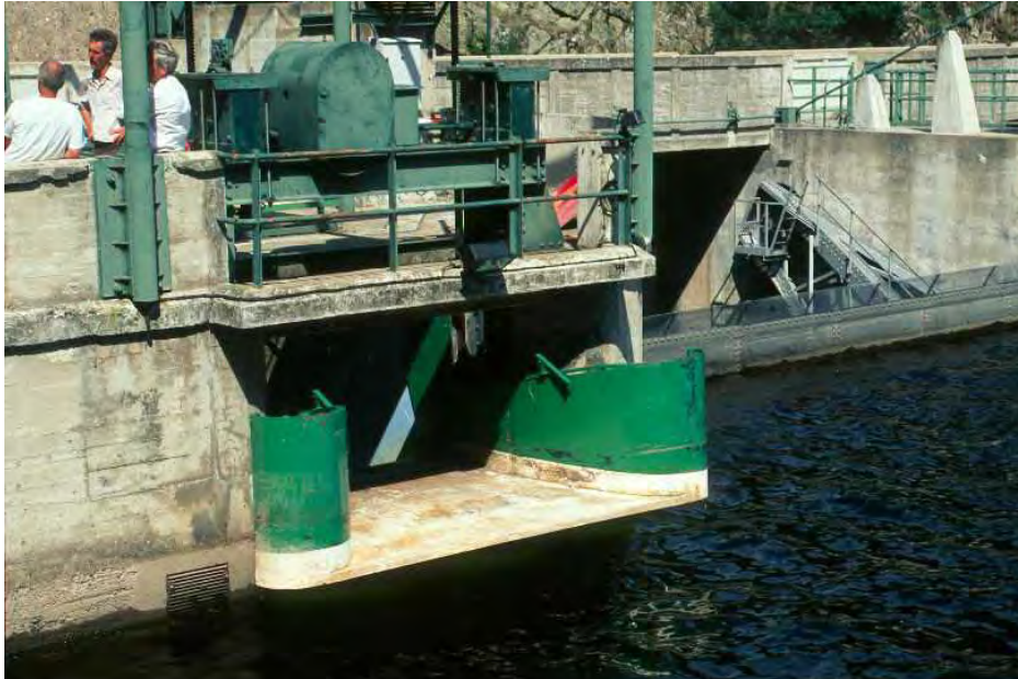
Abb. B. 20: Bypass-Düse für atlantische Lachsmolts mit Beleuchtung zur Verbesserung der Attraktionswirkung: Der Einlauf des Bypasses am Staudamm Poutès im Allier ist so geformt, dass möglichst geringe Turbulenzen entstehen und die Strömung stetig beschleunigt wird. Der Bypass ist höhenverstellbar und kann so an wechselnde Oberwasserstände angepasst sowie außerhalb der Betriebszeiten über die Wasseroberfläche emporgehoben werden.
