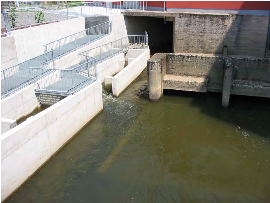
Abb. A.8: Unterwasseransicht der Wasserkraftanlage Klinkelsche Mühle in Gießen mit korrekter Anordnung des Einstiegs in die Fischaufstiegsanlage
