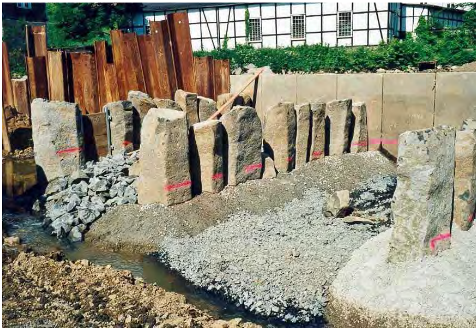
Abb. A.20: Raugerinne mit Beckenstruktur im Bau- Riegel aus großen Wasserbausteinen, raue Sohle mit filterstabilem Aufbau (Betzdorf/Sieg, Rheinland-Pfalz)
