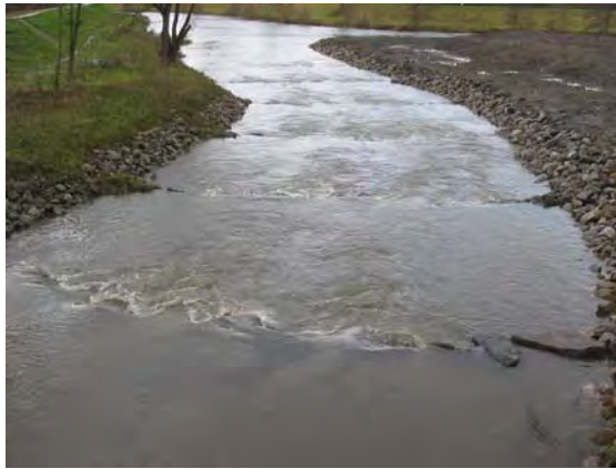
Abb. B. 15: Umgehungsgerinne Hambeek mit Riegelstruktur, rechts der optimierte Einstieg unmittelbar neben dem Wehr
