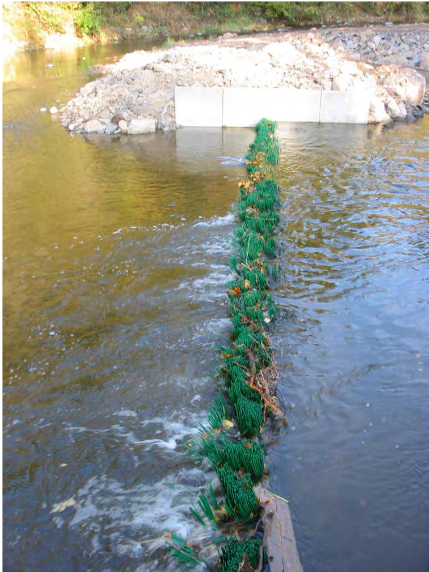
Abb. A.6: Aufwandersperre mit Borsten an der Mündung eines Unterwasserkanals (Our)
