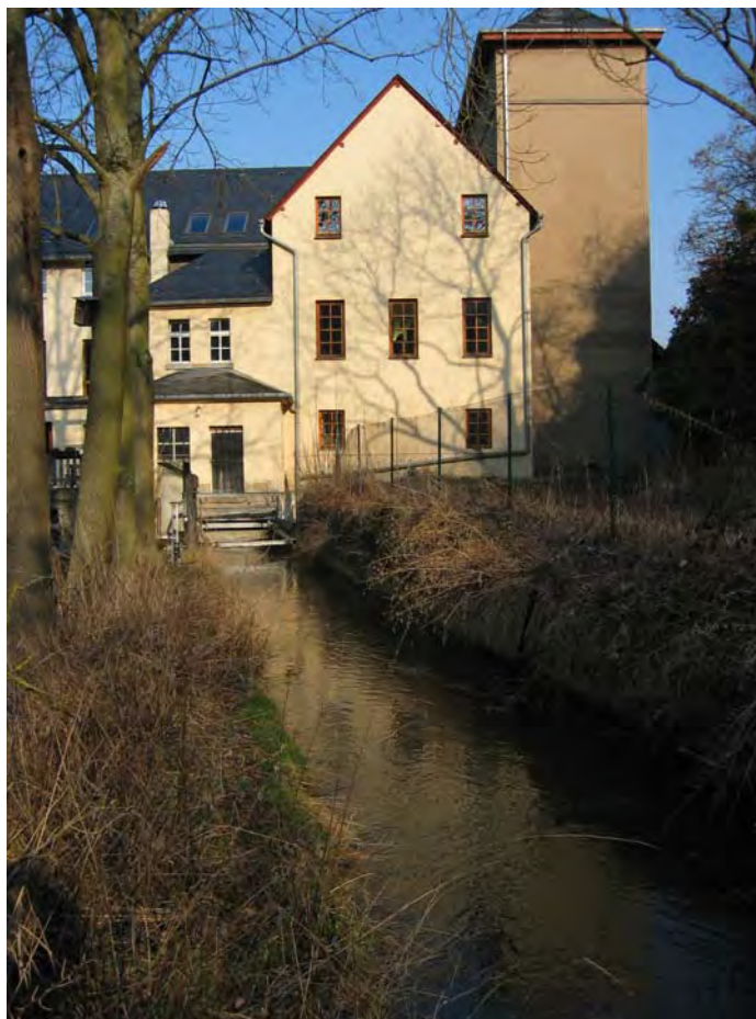
Abb. B. 4: Gesamtansicht Oberwasserkanal mit Rechenanlage
