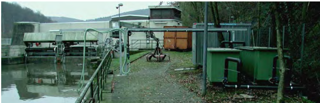
Abb. B. 23: Das Frühwarnsystem MIGROMAT® wurde erstmalig an der in Wahnhausen/Fulda zur Aal schonenden Steuerung einer Wasserkraftanlage eingesetzt.
