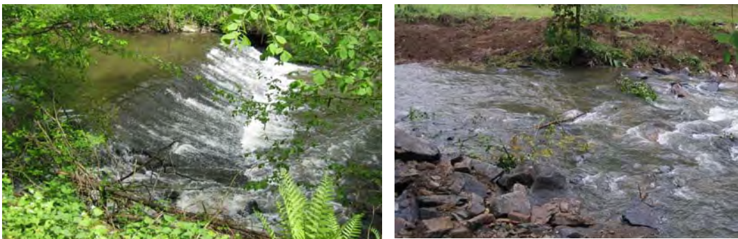
Abb. A.1: Wehr am Saynbach vor und nach dem Rückbau
