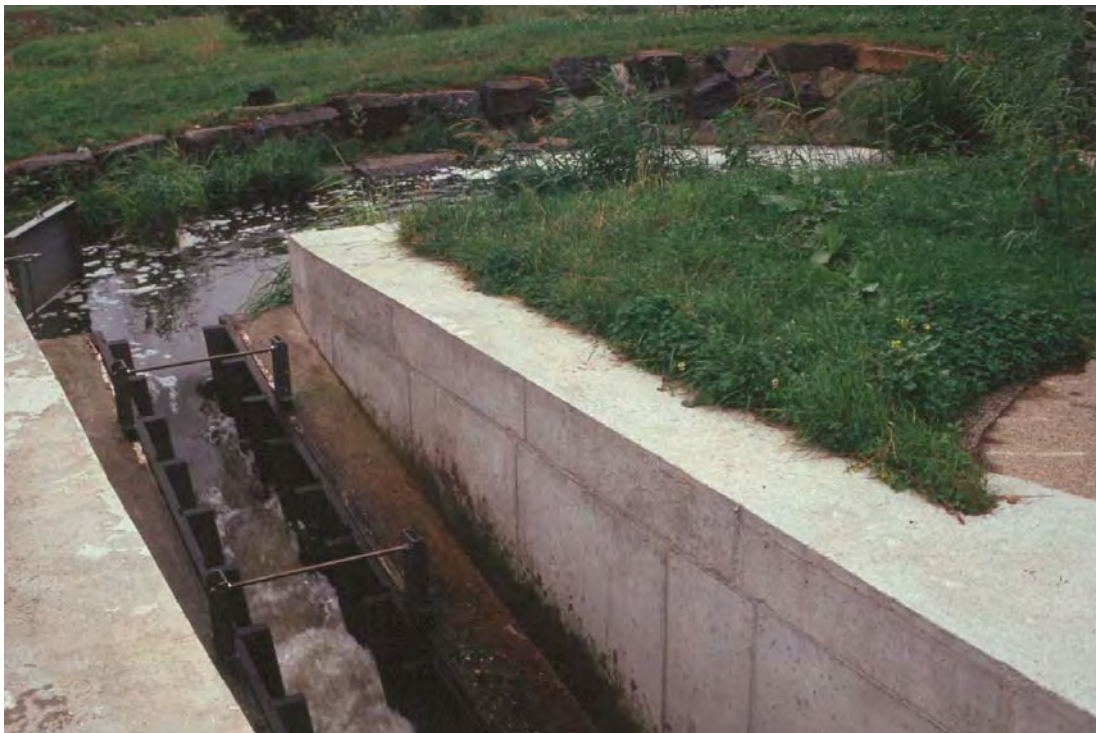
Abb. A.29: Denil-Pass am Kraftwerk Unkelmühle (Sieg) als Ergänzung zu der naturnahen Fischaufstieganlage am Wehr
