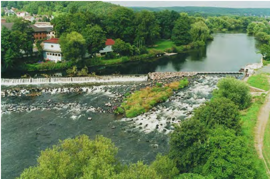
Abb. A.22 Fischaufstiegsanlage Buisdorf/Sieg. Raugerinne mit einer Mischung aus Querriegeln und Störsteinen und seitlicher Verschneidung, die jedoch nicht gut passierbar war. Daher wurde in diesem Bereich ein Vertical-Slot-Pass zusätzlich eingebaut. (Quelle: Städler)
