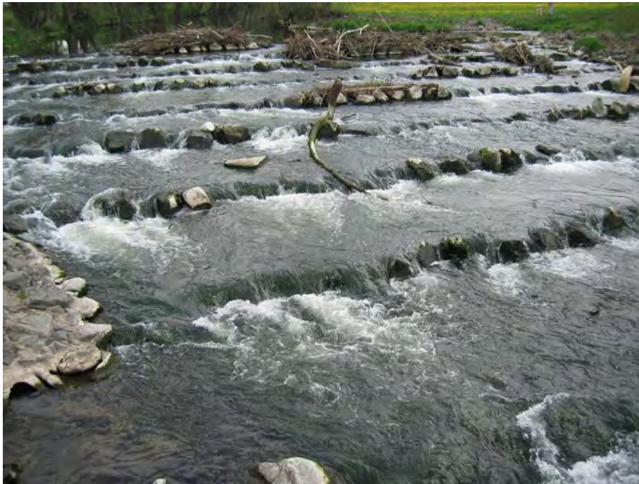
Abb. A.36: Fischrampe mit nicht überströmten Schwellen, an den sich Geschwemmsel verfängt
