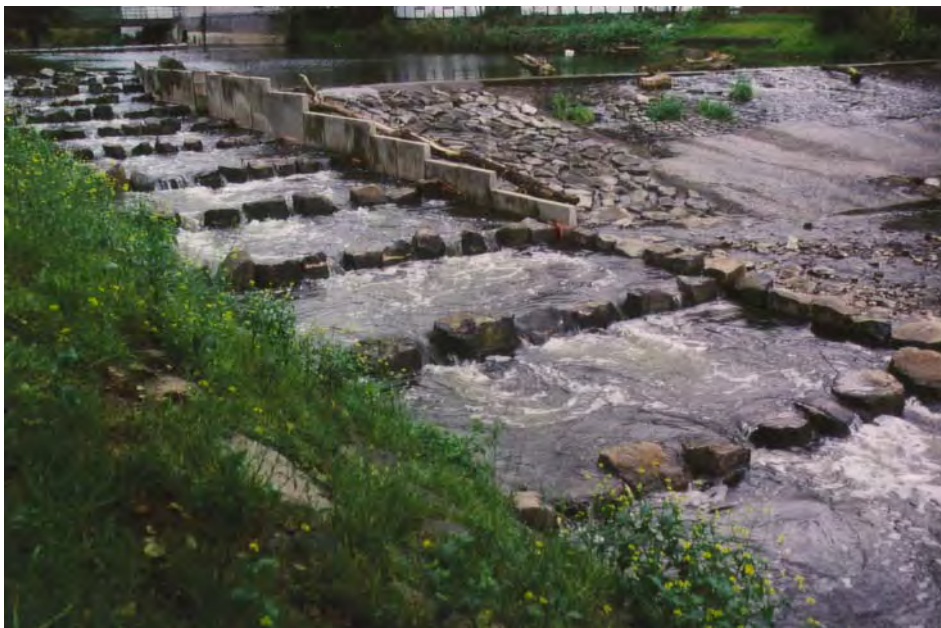
Abb. A.21: Raugerinne-Beckenpass Betzdorf (Sieg) im Betrieb ( Q = 500 \text{ l/s} ). Der unterwasserseitige Einstieg möglichst wurde nahe an den Wehrfuß gelegt und der Fischpass mit einer Trennwand in Richtung Oberwasser verschoben. Im Bild wird der gesamte Abfluss durch den Fischpass geleitet. Bei höheren Abflüssen wird das Wehr überströmt und der Unterwasserspiegel steigt an, wodurch der Einstiegspunkt in den Fischpass zum Wehrfuß hin verschoben wird.
