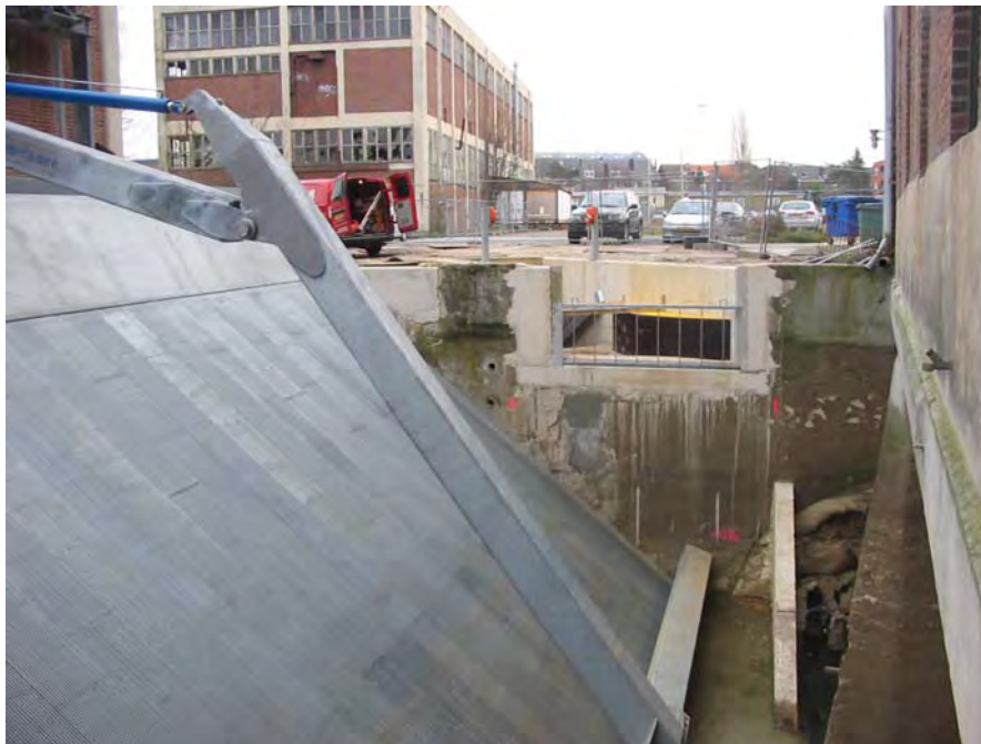
Abb. B. 18: Lachsabstieg ECI-Centrale in Roermond NL / Rur
