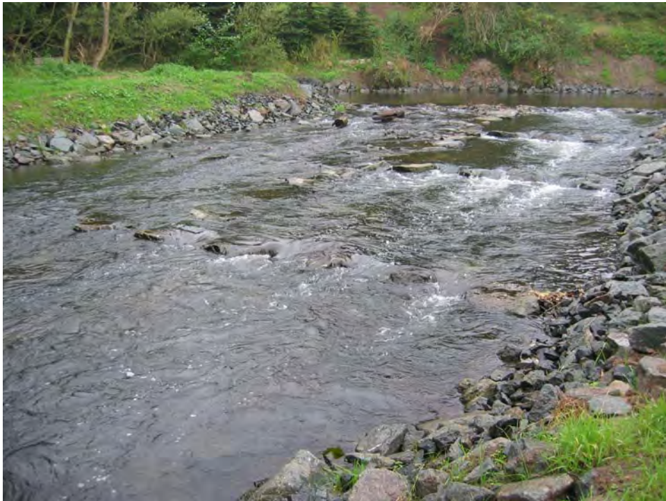
Abb. A.25: Geteiltes Raugerinne mit Beckenstruktur und flächigem Gerinne (Hasel). Rechts im Bild die Beckenstruktur
