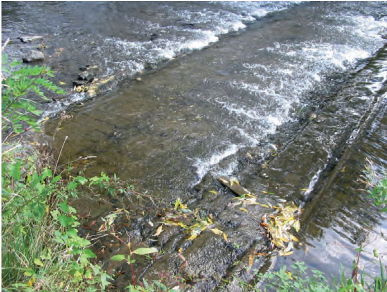
Abb. 4.5: Gleite in der Ahr bei niedrigem Abfluss. Bei höherem Abfluss ist der Standort für Lachse passierbar, daher Aufstiegsindex-Querbauwerk für Lachs 2.
