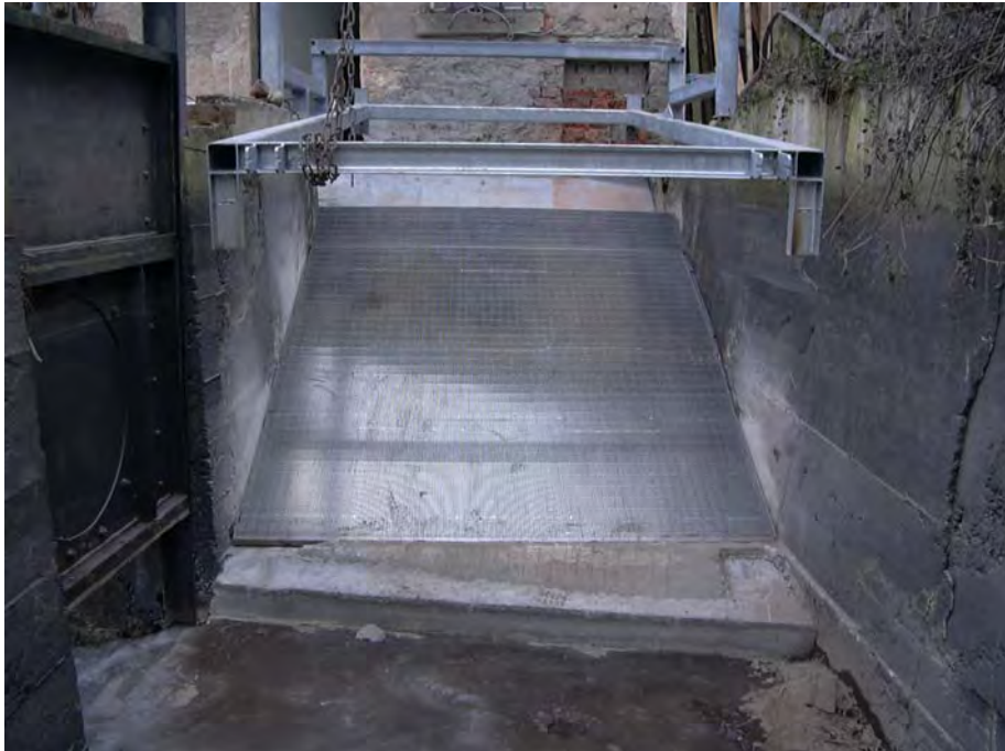
Abb. B. 5: Feinrechen Ochtendung (Nette) mit Rechenreinigungsmaschine während der Montage
