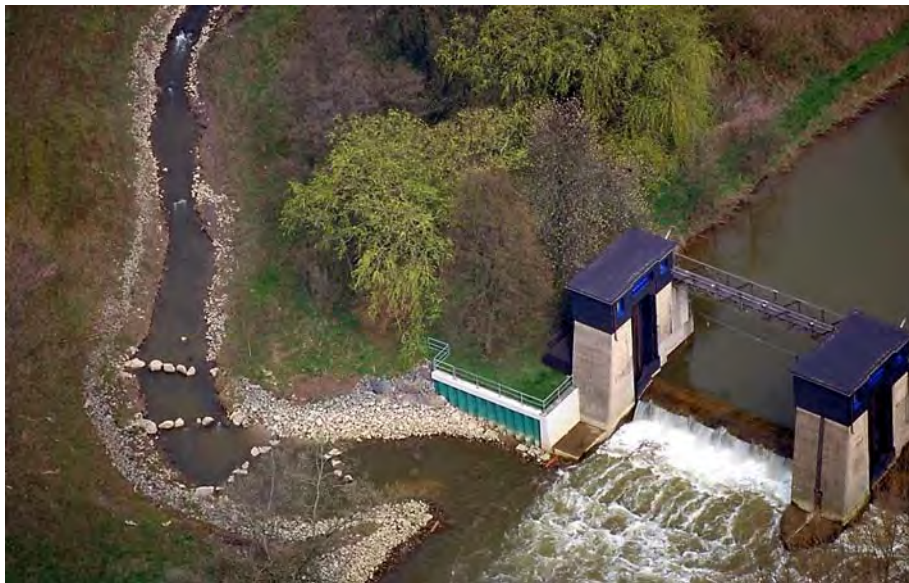
Abb. A.15: Luftaufnahme Wehr Beckinghausen/Lippe mit Fischaufstiegsanlage, die unterhalb des Wehrs gewandelt ausgeführt wurde, um eine gerichtete, zur Gewässerachse parallele Leitströmung zu erzielen (Quelle: Lippeverband)
