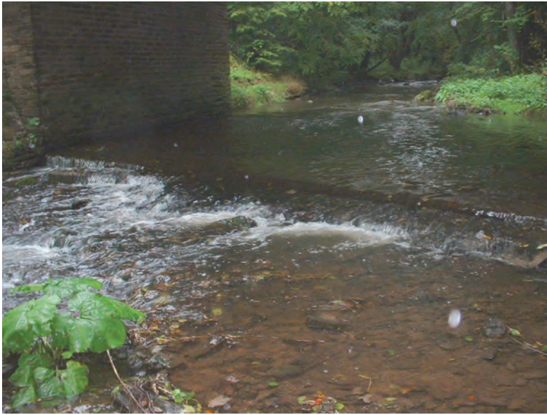
Abb. 4.9: Durchlass in der Alf bei niedrigem Abfluss. Der Aufstiegsindex-Querbauwerk für Lachs wurde zu 2 gewählt, da der Durchlass bei höherem Abfluss passierbar ist.
