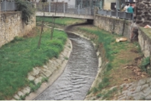
Gewässer eingetieft, Uferstreifen fehlt
