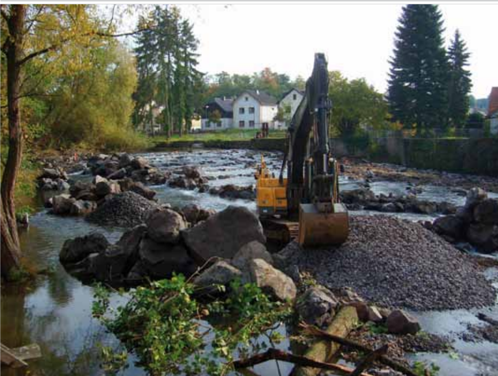
In den Querriegeln sind Lücken eingebaut, die so groß bemessen sind, dass sie für die größte Leitfischchart der Wied, die Barbe, gut passierbar sind.
