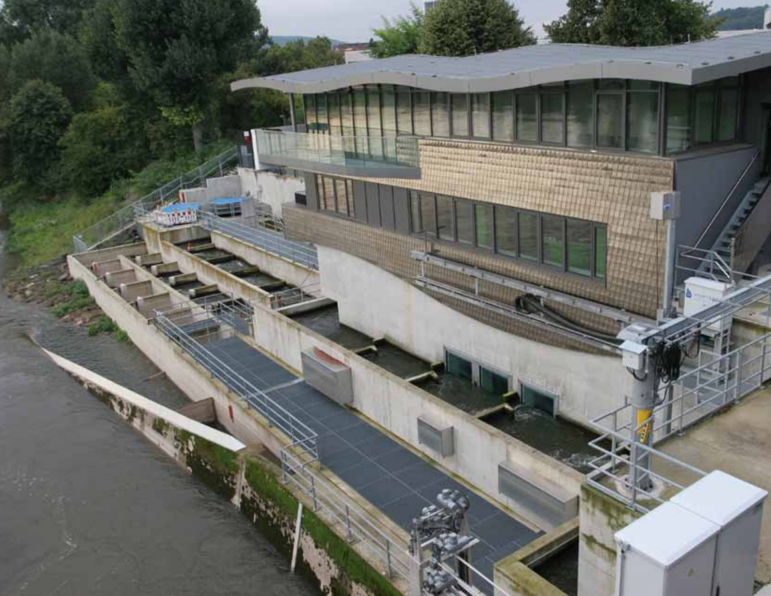
Hightech: Der neue Fischpass zählt mit seinen 39 Becken sowie der Fang- und Kontrollstation zu den modernsten Anlagen Europas. Eine eigens erzeugte Lockströmung weist den Fischen den Weg zum Einstieg. Ein Reiseziel, das Tor zur Mosel mit dem Besucherzentrum „Mosellum“.
