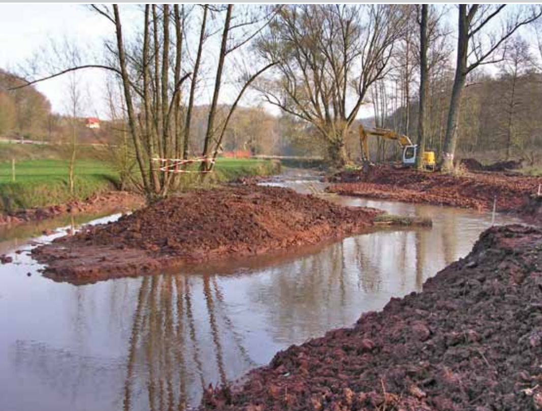
Durch Laufweiterungen verteilt sich die Energie des Hochwassers, die sonst im engen Bett die Sohle vertieft. Flussabwärts werden Ufer abgegraben und Ufersporne eingebaut. Zwei Altarme bleiben bestehen.
