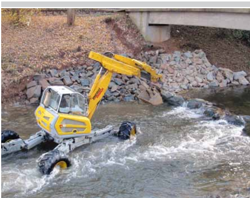
Der Bagger kommt. Ein sogenanntes Raugerinne in Riegelbauweise wird gebaut.
