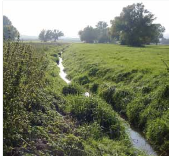
„Vorfluter“ Thürer Bach: Der begradigte, tiefer gelegte Bach sollte die dauerhafte Entwässerung der angrenzenden Wiesen garantieren. Allerdings wurde damit auch das Hochwasser verlagert.
