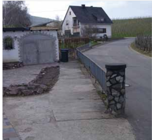
Vorher: Der Schantelbach verläuft unterirdisch rechts an der Garage vorbei.
