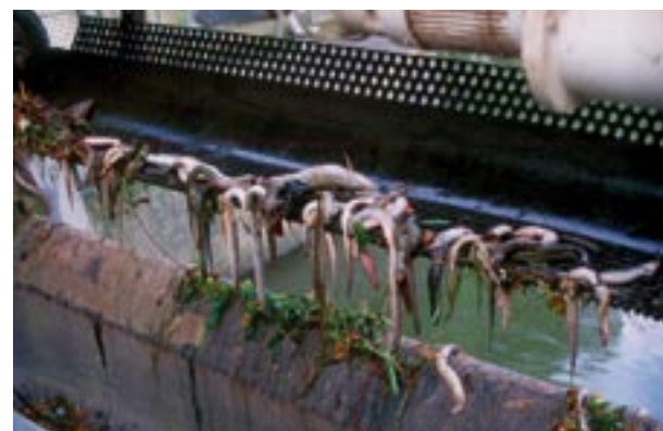
Rechenreinigung: Wenn die Anströmgeschwindigkeit zu hoch ist, werden die Fische an den Rechen gepresst und verenden.
