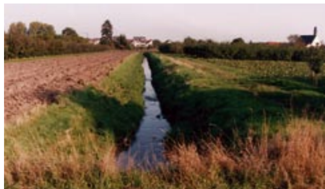
Der Neue Weinbach, begradigt, vertieft und strukturarm, vor der Renaturierungsmaßnahme.
