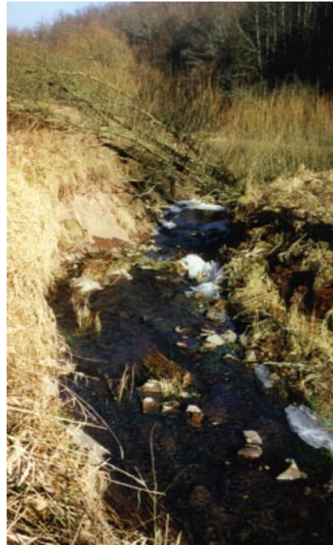
Erosionsstrecke des Eschelbaches. Hier wird kiesiges Material abgetragen...
