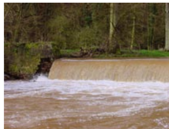
Die alte Wehranlage bei Altrich, 2,20 m hoch, stellte eines der größten Bauwerke in der Lieser dar. An ein Weiterkommen für Fische und andere Kleinlebewesen war hier nicht zu denken.
