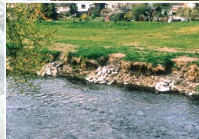
Zum Schutz der angrenzenden Sportanlage wurden 1994 am Prallufer der Ahr bei Altenahr-Kreuzberg Ufernischen angelegt.
