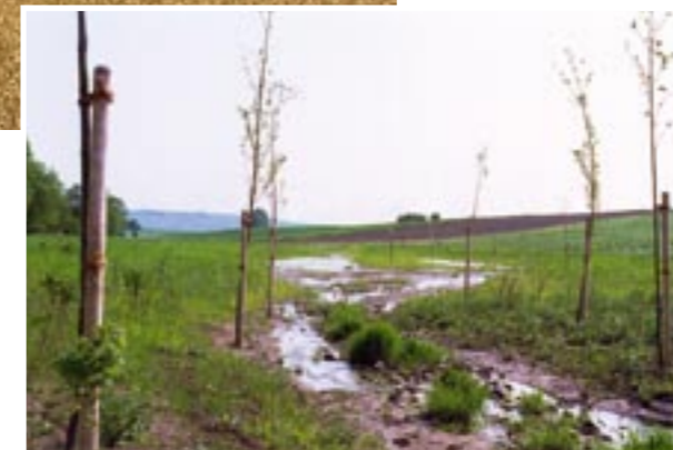
Die alten Sohlschalen wurden entfernt. Das Bild zeigt den Saubach kurz nach der Fertigstellung des neuen Bachbettes im Jahr 1999.
