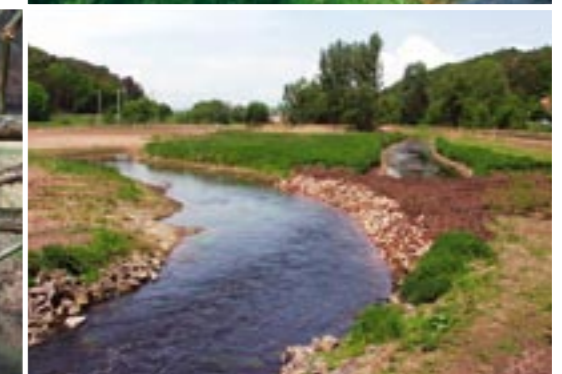
Mit der teilweisen Abgrabung der Aue wurde die Vernetzung zwischen Gewässer und Aue aufgewertet, neue Überflutungsräume geschaffen. Breite Gewässerrandstreifen begleiten den Gewässerlauf.
