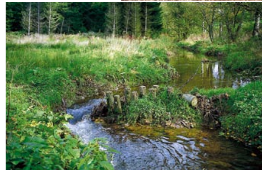
Im Jahr 2001 hatte der Bach bereits sichtbar an der Uferböschung "geknabbert".
