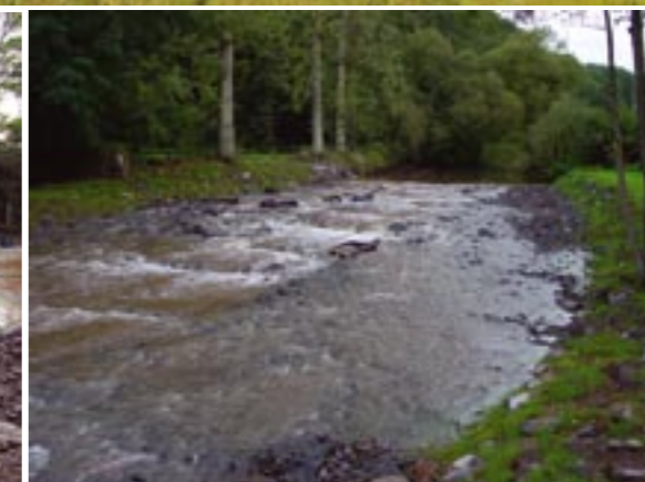
Die neue Rampe erreicht bei einer Neigung von ca. 1:25 eine Länge von fast 50 m. Sie ist so gestaltet, dass sie auch bei Niedrigwasser voll funktionstüchtig ist.
