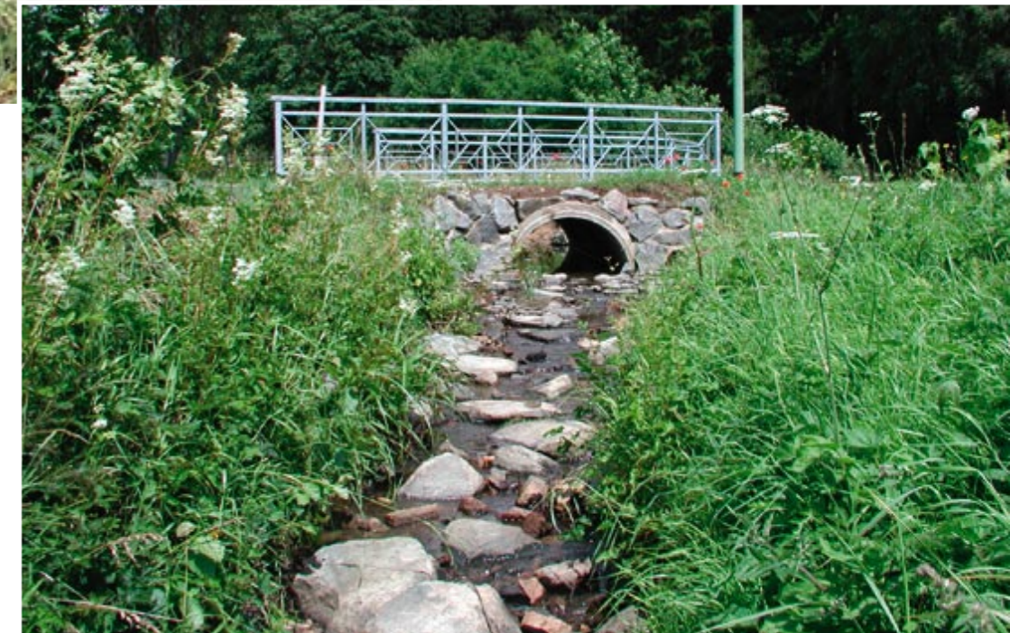
Beide Rohrdurchlässe wurden durch einen neuen ausreichend großen Rohrdurchlass NW 1400 ersetzt. Dieser wurde zur Hälfte in das Gewässerbett eingegraben und mit Sohlsubstrat gefüllt. Die unterhalb des Durchlasses vorhandene Befestigung der Gewässersohle mit Rasengittersteinen und die anschließende Auskolkung wurden in eine Sohlgleite umgewandelt.
