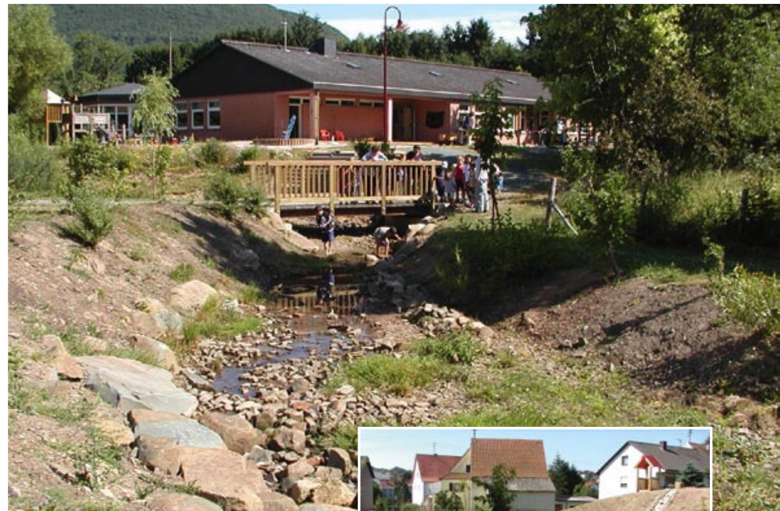
Der Oderbach wurde in das Gelände des Kindergartens integriert und naturnah umgestaltet.
