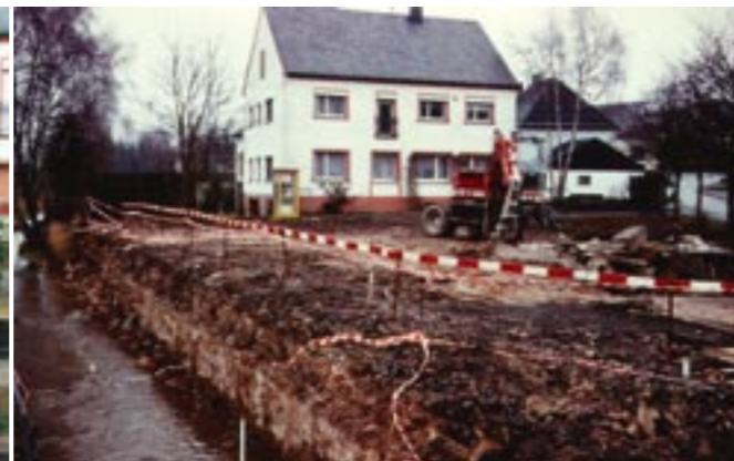
Offenlegung der Ruwer, Abbruch der Überbauung
