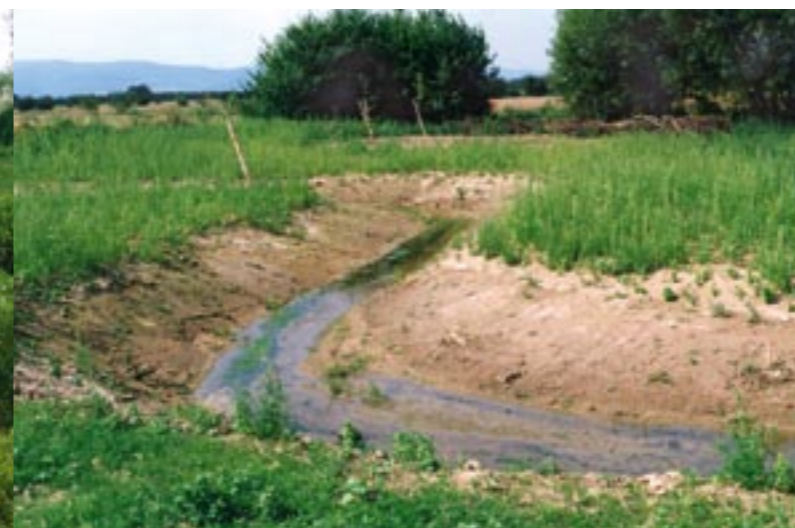
Das neue Bachbett wurde nur grob vorgegeben. Zustand im August 1996
