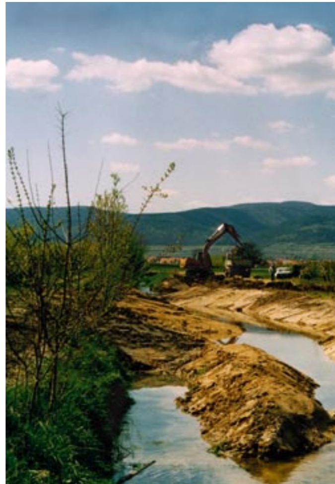
Ein rund 160 m langer neuer Gewässerlauf mit flachen Böschungen entsteht. Im Vordergrund ist ein Teil des alten Bachbettes als Altarm zu sehen. Unterstützt wurde die Renaturierung vom Gewässerzweckverband "Isenach-Eckbach"
