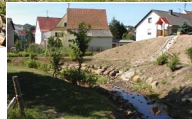
Die Aufnahmen zeigen den Zustand kurz nach Abschluss der Arbeiten im Sommer 2002. Mittlerweile sind die Ufer des Oderbaches bewachsen, der renaturierte Bereich fügt sich harmonisch in das Ortsbild ein.
