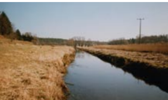
Die in den 30er Jahren tiefer gelegte und befestigte Sohle, die befestigten Ufer und der gerade Gewässerverlauf waren markante Kennzeichen des Kulturwasserbaus. Das ökologische Wirkungsgefüge zwischen Aue und Gewässer war nachhaltig gestört.
