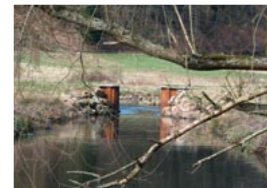
Mehrere Querverwallungen in der Aue bewirken einen zusätzlichen Wasserrückhalt. Der hier gezeigte Dammdurchgang bleibt ökologisch durchgängig.
