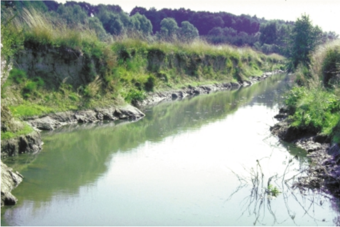
Bild 1: Der Holzbach bei Dierdorf vor der Renaturierung. Dieser Gewässerzustand war die Folge eines landwirtschaftlichen Gewässerausbaus in den 30er Jahren.
