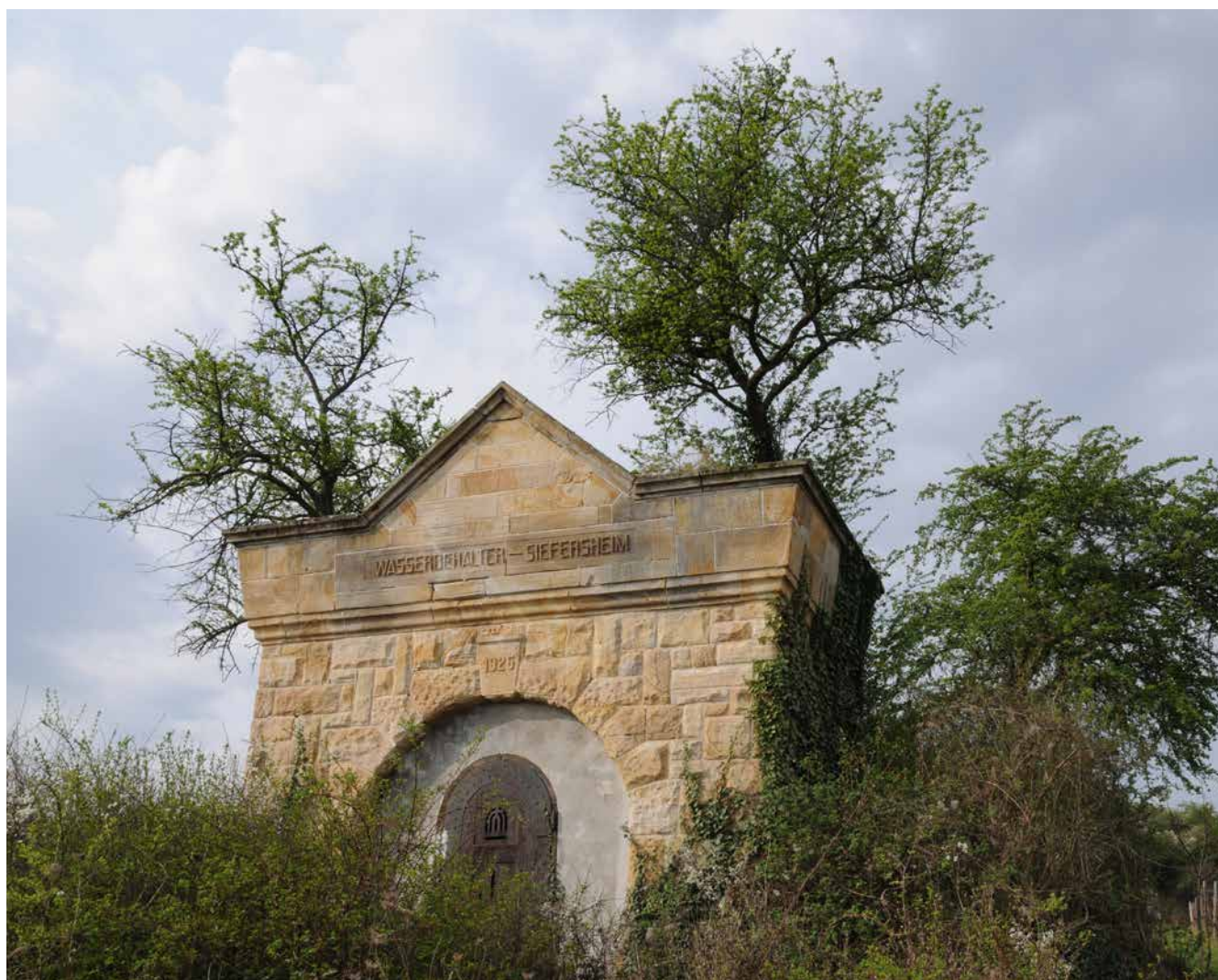
Alter Wasserbehälter in Siefersheim/Rheinhessen
