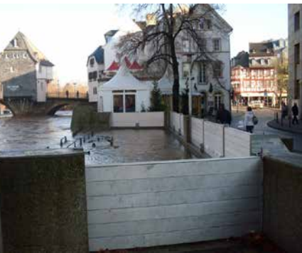
Hochwasserschutzmaßnahme in Bad Kreuznach an der Nahe
