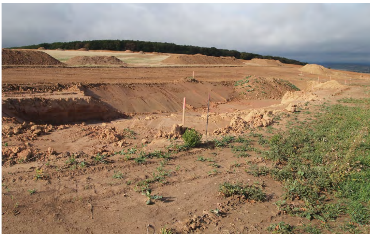
Erschließung eines Neubaugebietes, Abtrag von Bodenmaterial
