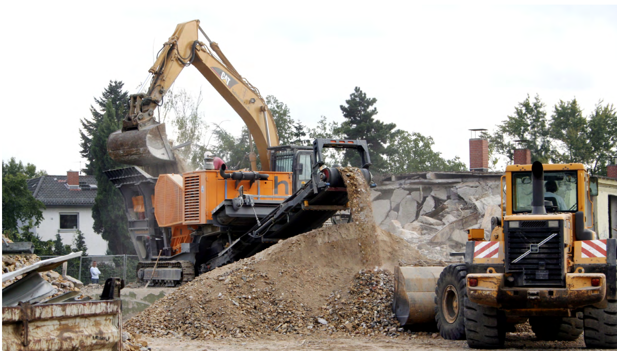
Aufbereitung direkt auf einer Baustelle
