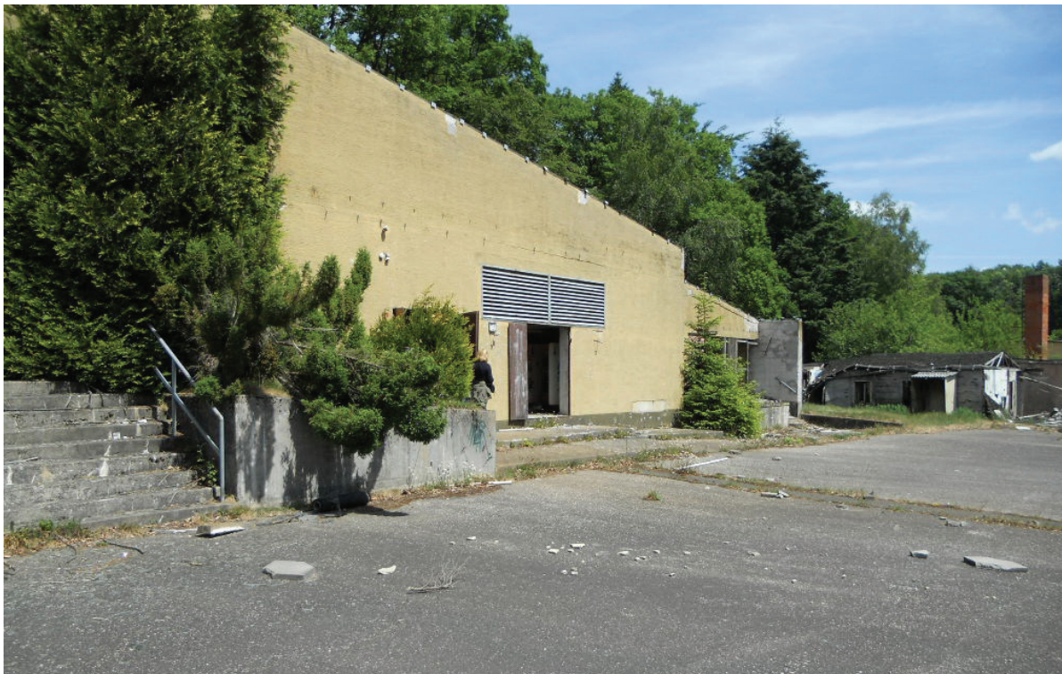
Abb. 24: Ehemalige militärische Liegenschaft
