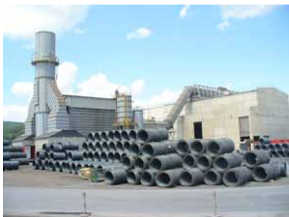
Abb. 22: Neue Abgasreinigungsanlage mit Kamin
