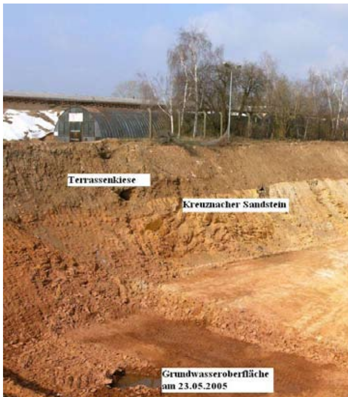
Abb. 4: Schichtfolge im Bereich der Baugrube
