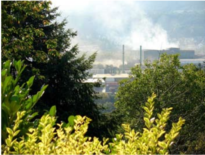
Abb. 4: Emissionen beim Stahlwerkbetrieb
