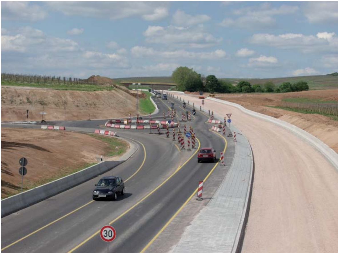
Abb. 1: Ausbau der B41 bei Bad Kreuznach
