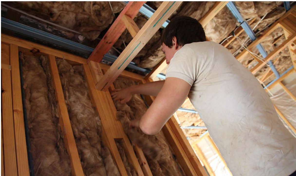
Anbringen von Wandisolierung.
