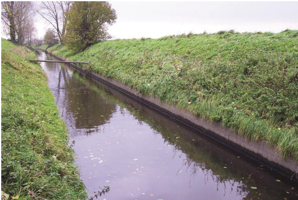
Abb. 2: Isenach-Unterlauf bei Flomersheim. Harter Gewässerausbau mit Beton-Kastenprofil und fehlender Ufergehölzsaum kennzeichnen die monotone Gewässerstruktur. Die organische Belastung reicht bis in den Bereich starker Verschmutzung (Gewässergüteklasse III). Der ökologische Zustand ist unbefriedigend bis schlecht.
