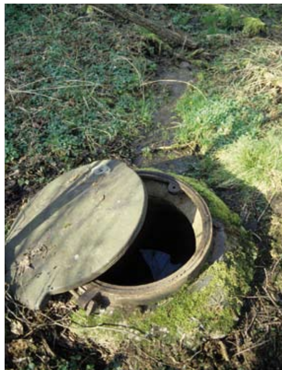
Solche alten Brunnenstuben können u. U. wieder geöffnet und revitalisiert werden.
