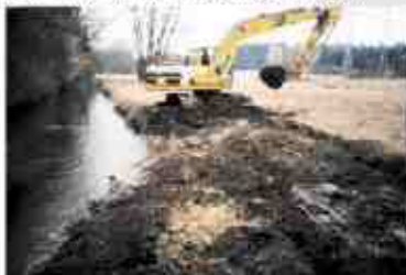
Baustufe (Februar 1998) Abflachen der Uferböschung zur Stärkung der Eigenökonomie
