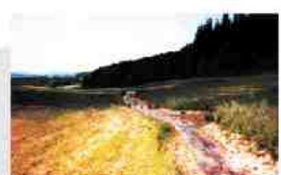
Herstellung eines offenen Gewässerbettes
