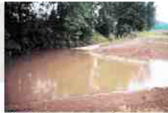
Nach Profilierung der neuen Gewässer und Müllen geringer Anbau des Wiesbaches zwecks Flutung der Aue
