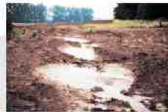
Eine Grobprofilierung des neuen Gewässers in der Aue reicht aus
