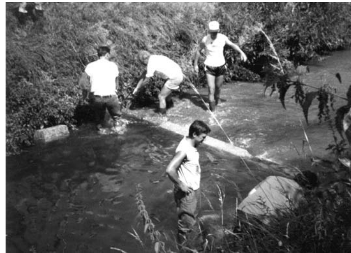
Einbau von Sohlswellen mit Hilfe des THW
