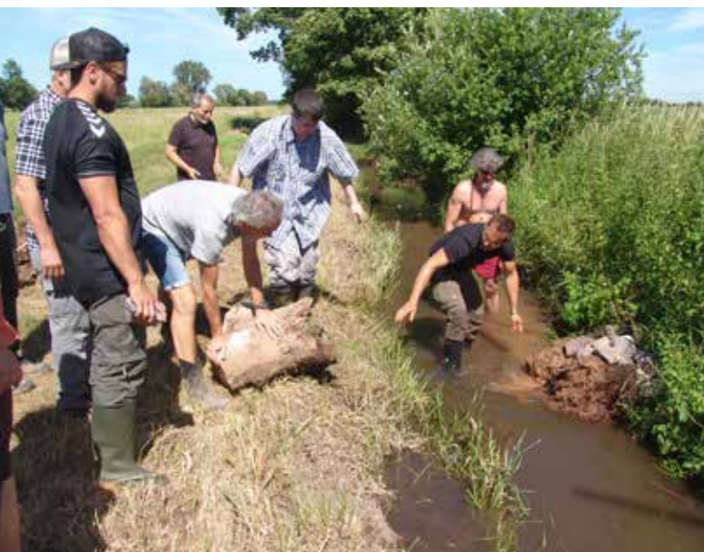
Einbau von Strömunglenkern
