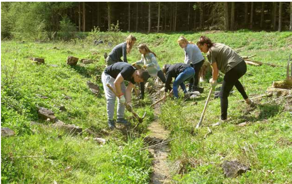
Los geht's: Die Stickungen werden entfernt und anschließend als Strömungslenker eingebaut
