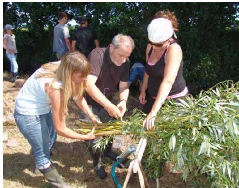
Bau einer Faschine
