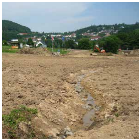
oben: Zulauf zum Pützbörner Bach vor der Renaturierung unten: Renaturierung mit Gewässerentwicklungskorridor
