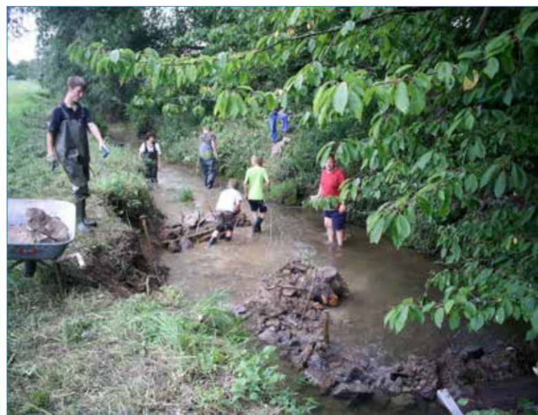
Lokal aktiv: Der ASV Petri Heil aus Bad Bergzabern errichtet am Erlenbach Steinriegel zur Erhöhung der Strömungsdiversität
