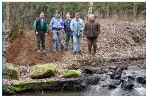
Nachher: Ausbau einer überwindbaren „Rampe“
