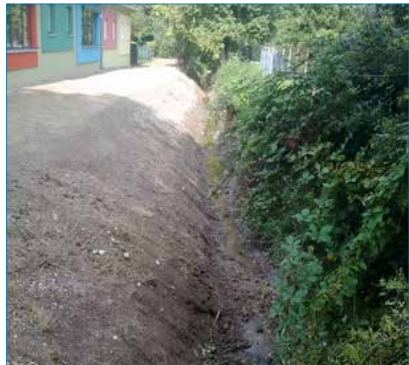
Nach der Pflegemaßnahme
