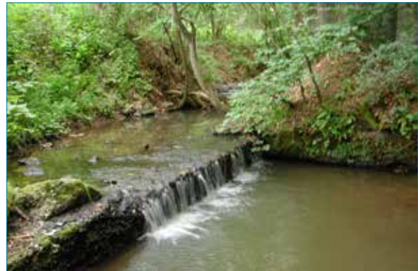
Vorher: kaum überwindbarer Absturz
