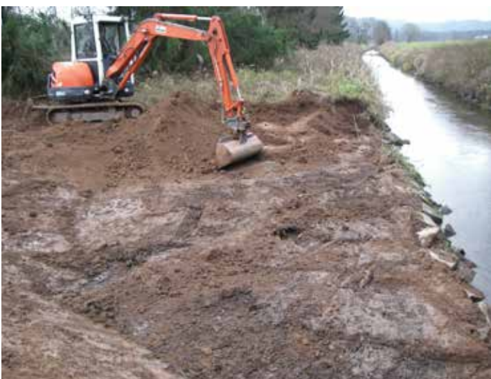
Ausbau der Überflutungszone
