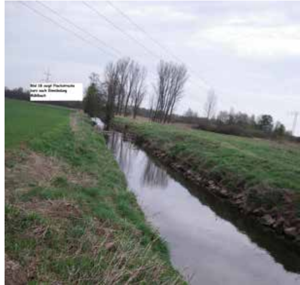
Kanalisiertes Abschnitt des Glan vor Beginn der Maßnahmen
