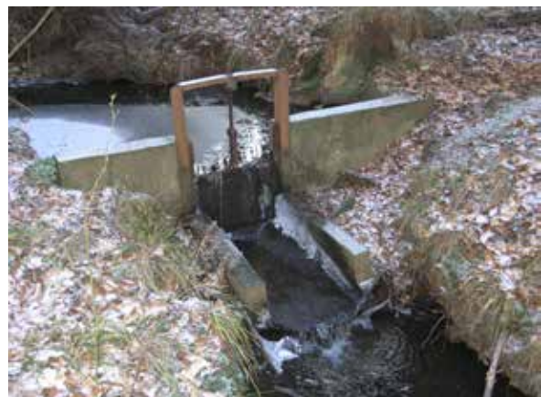
Regelwerk für Zufluss
