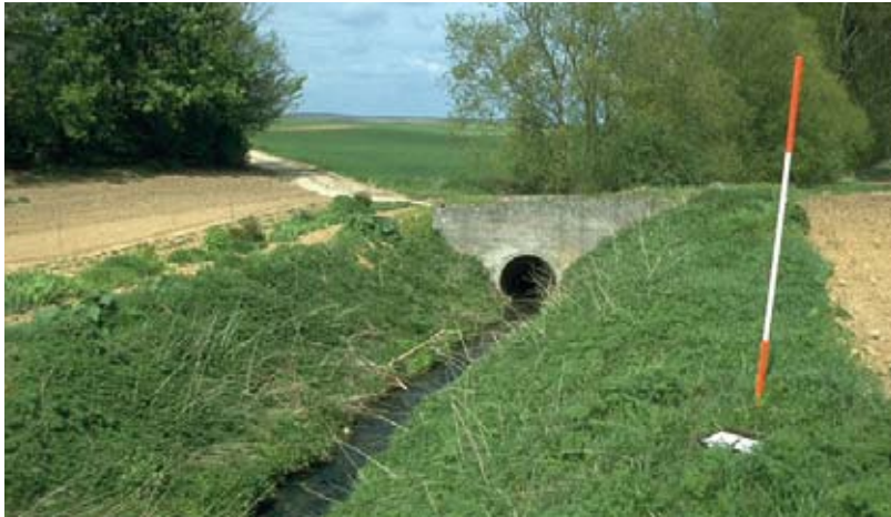
Böschungen in Trapezform werden regelmäßig gemäht.
