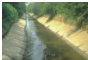
Güteklasse 7: übermäßig geschädigt
