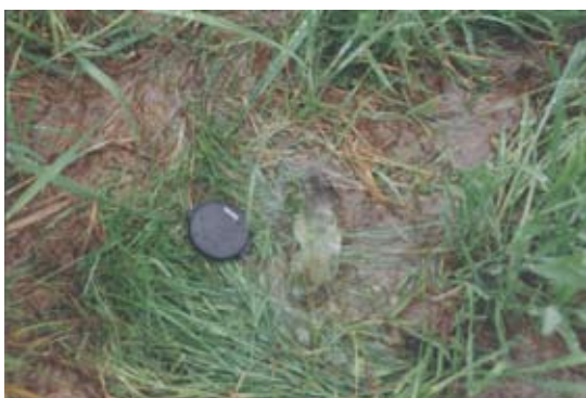
Foto 18: Der Ausfluss einer Pipe (Mausloch) während eines anhaltenden Niederschlages. [Foto: S. Scherrer]
