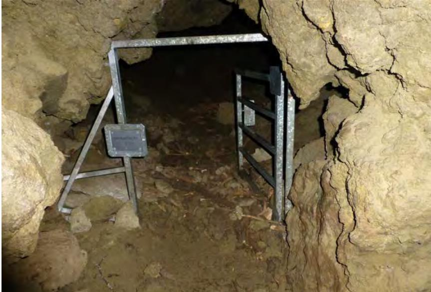
Sicherung und Verschließen von offenliegenden Eingängen der Eishöhlen durch den NABU Kylleifel mit Gitter und Zumauern.
