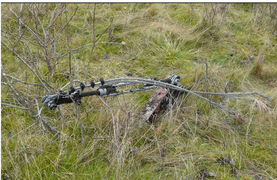
Einbetonierte Verankerung des ehemaligen Funkmastes der DECCA-Station.
