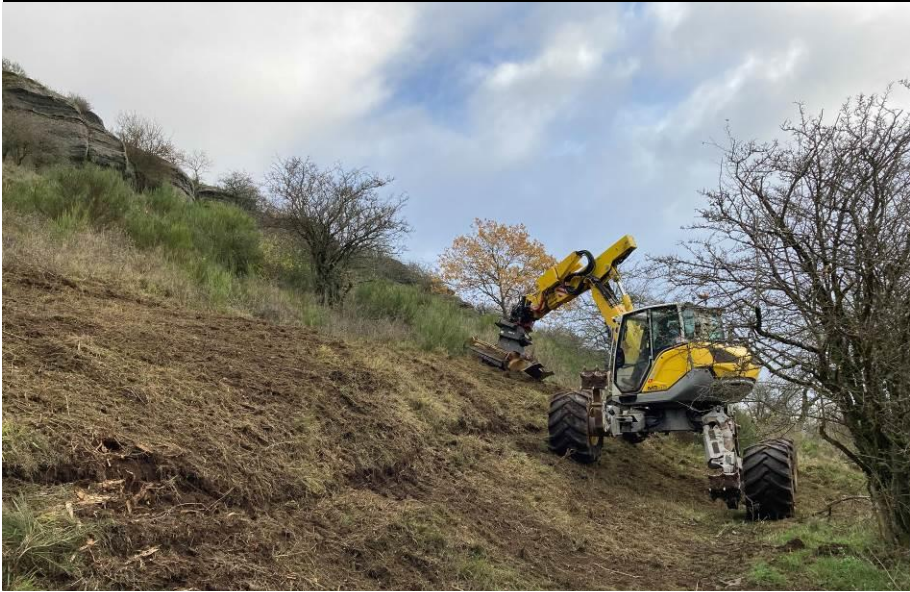
Schreitbagger bei Nach- pflegearbeiten im Steil- hang an der Südseite
