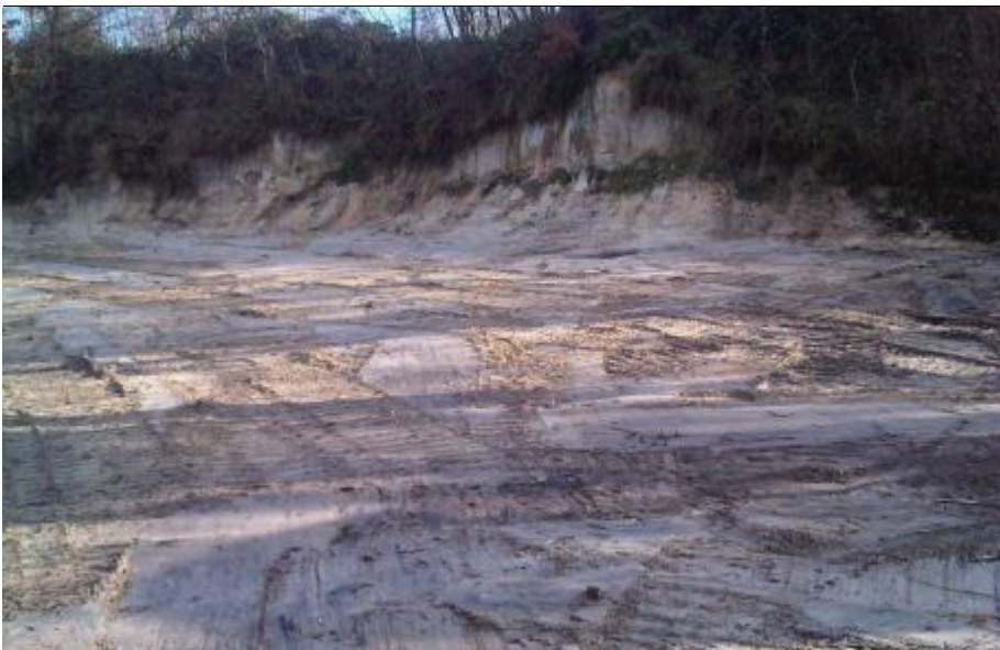
...direkt nach dem Abschieben mit schwerem Gerät
