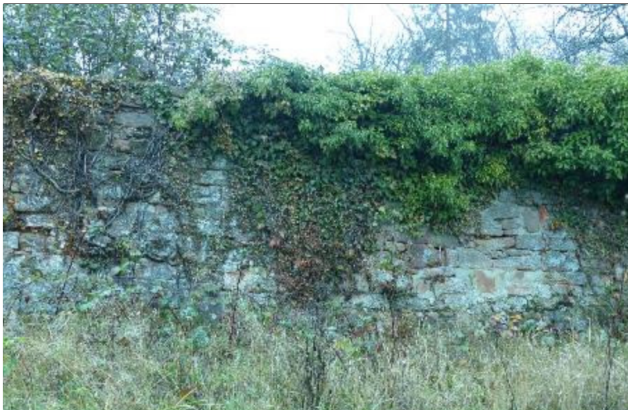
Maueraspekt des Slevogthofes
