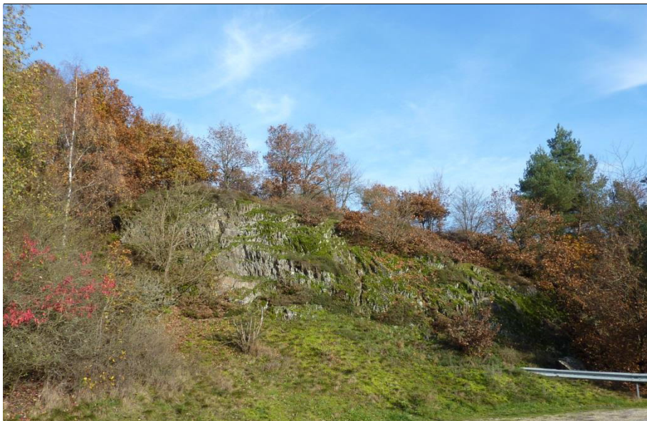
„Heide Hauserbachsee“, Aspekt der Felswand mit Heide, entbuschter Zustand im Herbst
