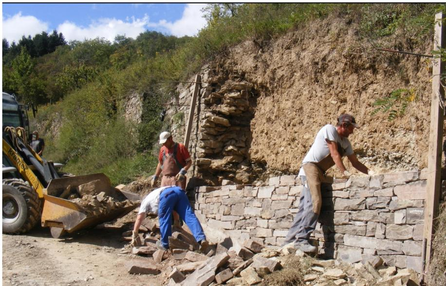
Wiederherstellung eines Teilstücks der Trockenmauern entlang des Ellingsweges im Rahmen der Bodenordnung
