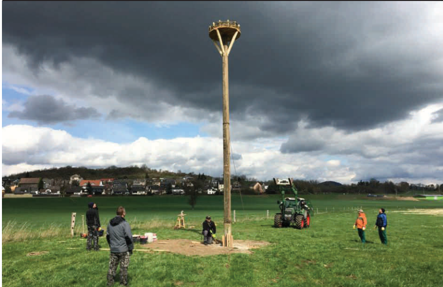
Errichtung einer Storchplattform im April 2016.
