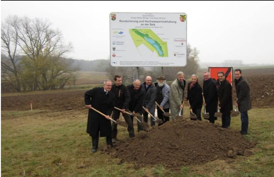
Beginn der Renaturierungsarbeiten durch den Selzverband im November 2011
