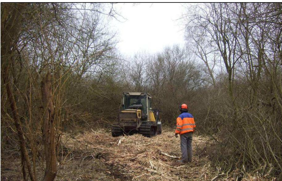
Im Februar 2011 wurden stark verbuschte Bereiche des NSG mittels Kettenraupe und Forstmulcher gerodet, um die Flächen für die Anlage der Gewässer vorzubereiten
