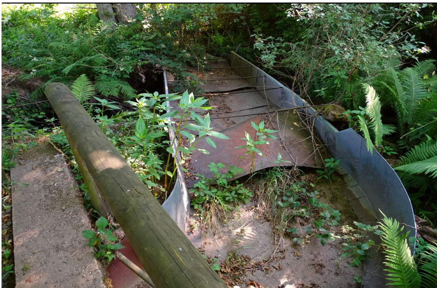
Teil des ehemaligen Stauwehrs
